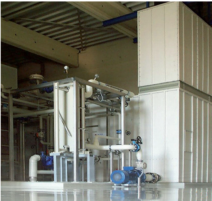
Der Absorptionstrockner arbeitet auf Basis einer Salzlösung; auf den Einsatz mechanischer Kälteerzeugung kann verzichtet werden
